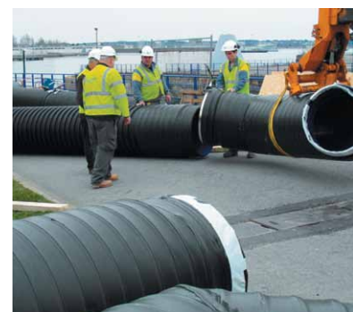
Formation soudure électrofusion sur chantier.
