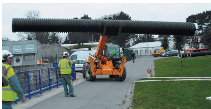
Livraison chantier de barres de 12 metres utile.
