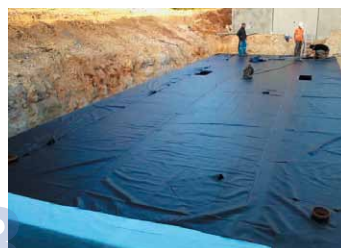
3 Etanchéité par géomembrane
