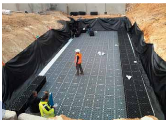
2 Pose des modules
