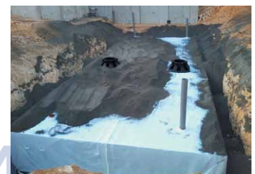
4 Remblai du bassin incorporant les puits d'accès verticaux et les événements
