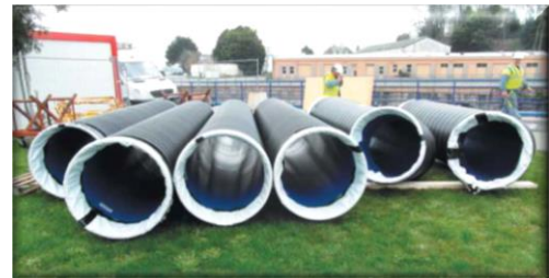
Hydrotub XL Ø750 mm avec joints electrofusion.
